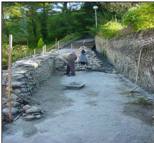
Muret en contrebas de Sainte-Croix à OLRON SAINTE-MARIE.
