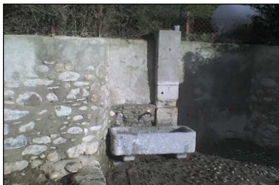
Fontaine de TROIS-VILLES après rénovation
